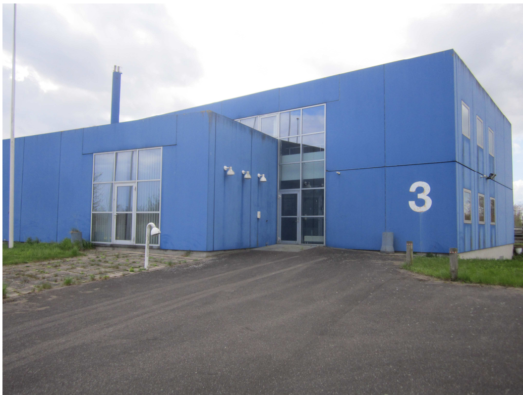
Det er den tidligere administrationsbygning for VEGA der har sat gang i ideen om at der kan ske en oparbejdning af affaldet fra den nærliggende genbrugsplads.
